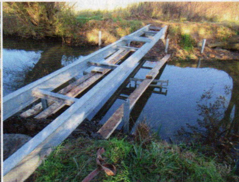
Trägerunterbau einer Fußgängerbrücke
