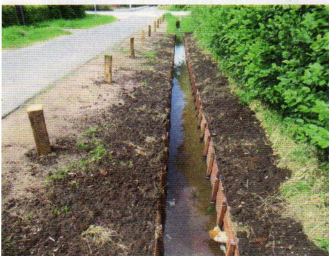
Grabenfußsicherung mit Holzflechtmatten
