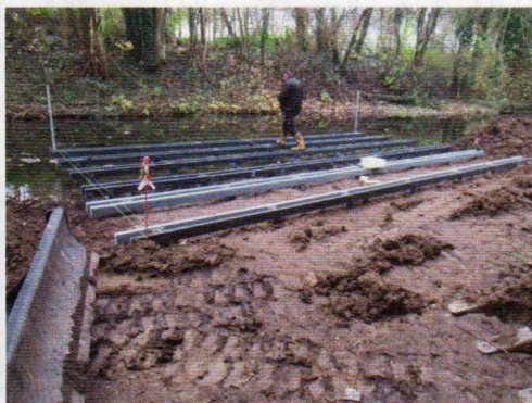
Unterbau des Steges zum Anlegen von Kanuten
