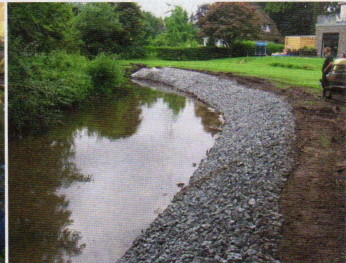
Alsterböschungssicherung mit Steinwalzen
