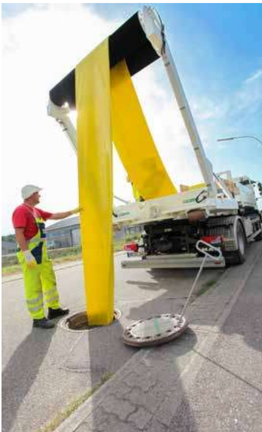
Sanierung einer Abwasserleitung im Schlauchlining-Verfahren.
