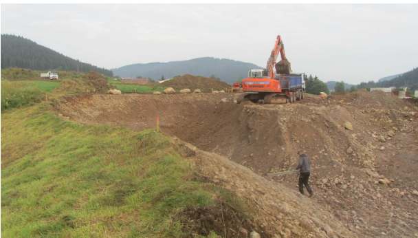
Bau eines Versickerungsbeckens im Gewerbegebiet Titisee-Neustadt
