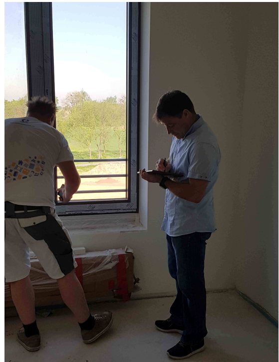
Dirk Eckardt überprüft die per Laserdistanzmesser gemessenen Ist-Werte mit dem geplanten Werten, greift diese in DIG-CAD ab und übergibt sie an MWM-Libero.
