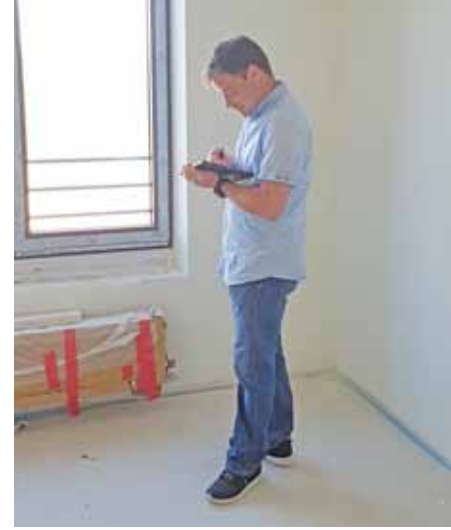
Dirk Eckardt gibt die Maße für die Fensterlaibungen ein.
