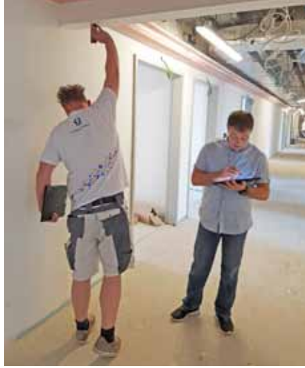
Dirk Eckardt überprüft die per Laserdistanzmesser gemessenen Ist-Werte mit den geplanten Werten.
