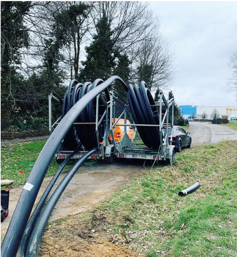
Bei der Horizontalbohrtechnik ist der münsterländische Betrieb Eggert federführend. Seit zehn Jahren nutzt das Unternehmen Software von MWM.
